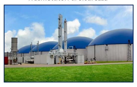
I biogas sono miscele di vari tipi di gas, prevalentemente gas metano, prodotti sia tramite il processo di respirazione anaerobica, quindi senza presenza di ossigeno, sia tramite la respirazione aerobica, da letami, fanghi o decomposizione di rifiuti.
