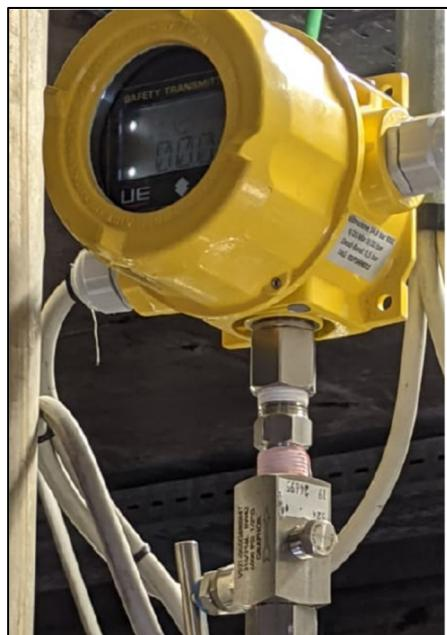
Dando uno sguardo più approfondito allo strumento – che dispone anche di versioni differenziali e di temperatura – a fianco del relay di sicurezza con portata fino a 6A a 250 VAC è disponibile una soglia collegabile a PLC per segnalare contemporaneamente l'avvenuto intervento del relay e quindi attivazione dell'elemento da controllare.
